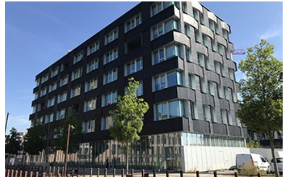
Photo credit: Création Bois Construction
