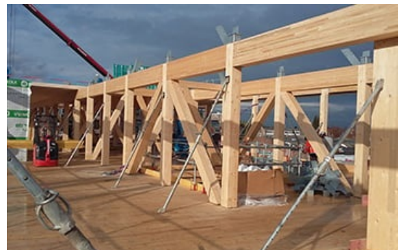
Photo credit: Création Bois Construction
