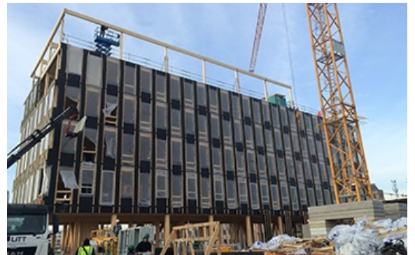
Photo credit: Création Bois Construction
