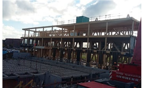
Photo credit: Création Bois Construction
