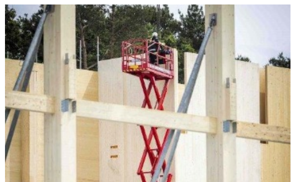
Photo credit: AF Bygg Väst
