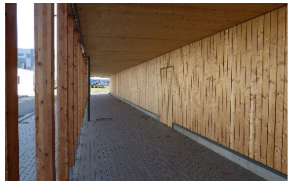
Photo credit: Création Bois Construction
