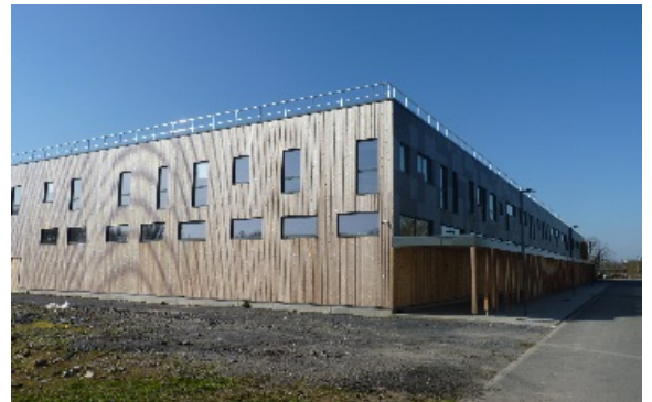
Photo credit: Création Bois Construction
