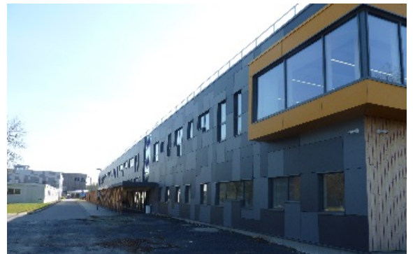
Photo credit: Création Bois Construction
