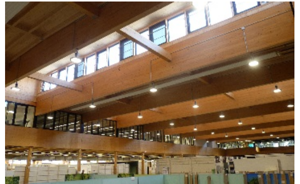
Photo credit: Création Bois Construction
